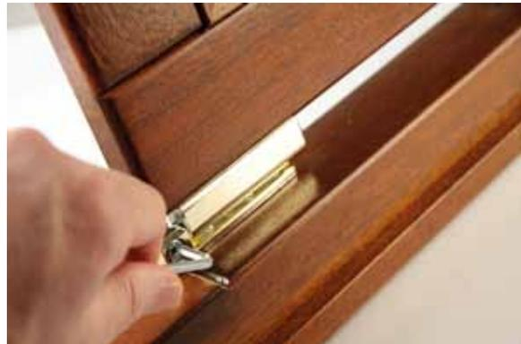
I meccanismi di sospensione e gli organi di manovra sono dotati di dispositivi che consentono precise regolazioni, al fine di favorire il corretto ed agevole utilizzo del serramento. La regolazione dei meccanismi di apertura permette in molti casi di ovviare a movimenti dimensionali minimi propri del legno.
